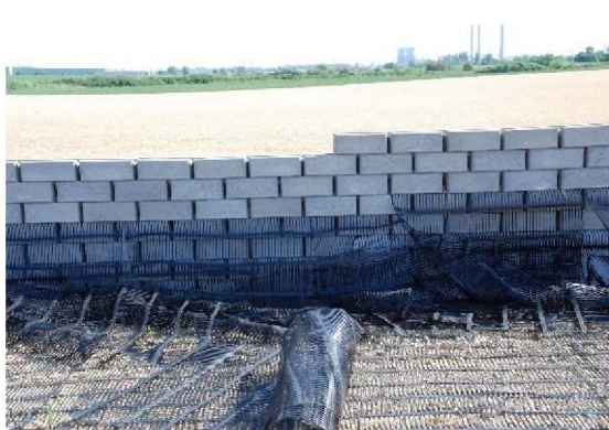
Relevu foto zid pământ armat cu parapet din blocheți
