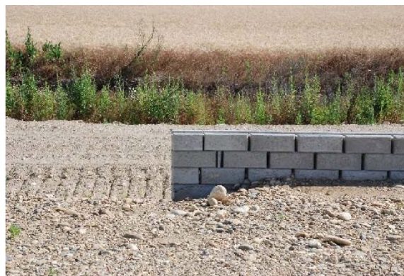
Relevu foto zid pământ armat cu parapet din blocheți
